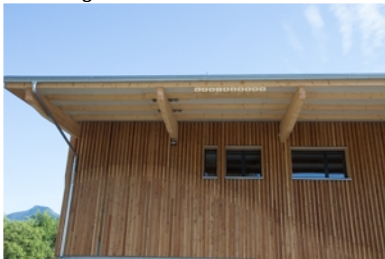
ABBILDUNG 8: NISTHILFEN AM NEUEN WERKHOF IN BAD RAGAZ
